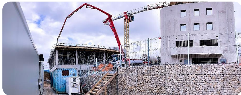
Chantier Aubagne-Allamanno pour la construction de 2 bâtiments, BESS loué pour 1 an avec la grue
