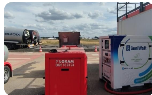
Installations hybrides sur le chantier de l'aéroport Charles de Gaulle (Paris), pour l'alimentation des bases vie
