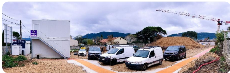
Chantier Aubagne-Trevo BTP pour la construction d'un bâtiment, BESS loué pour 6 mois avec la grue
