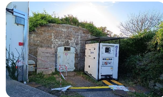
Installation Hybride Max (GE B100, BESS 90/120 et PV) pour la production d'énergie de l'île de Chausey
