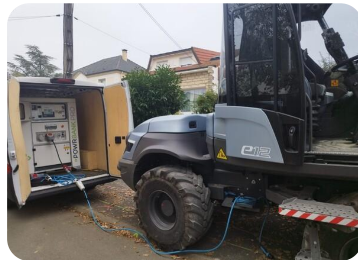
Recharge d'un engin électrique sur chantier Zéro Emission en région parisienne
