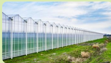
Production de chaleur
